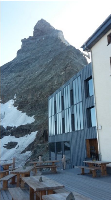
Blick von der Terrasse der Hörnlihütte auf den Hörnligrat
